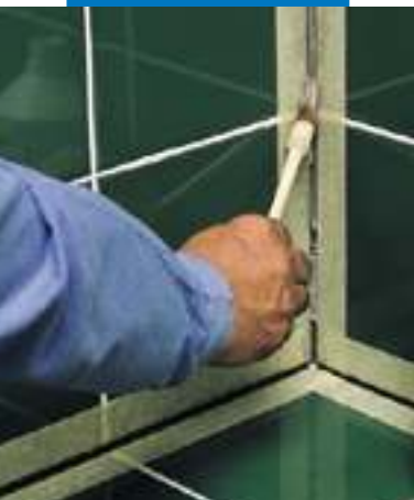
Application of Primer FD
